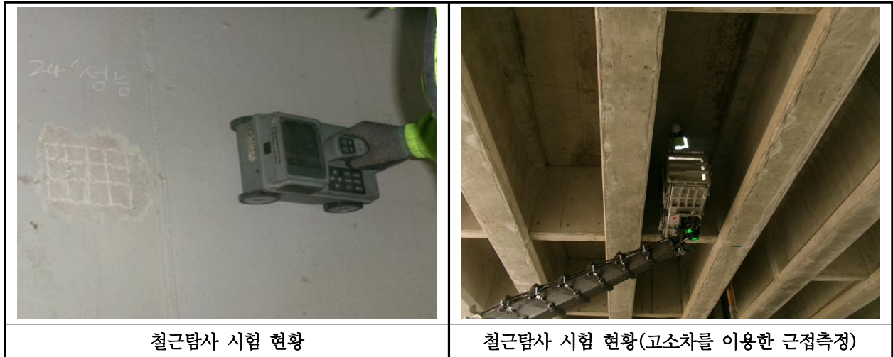
【사진 1.4.2】 철근탐사 시험
