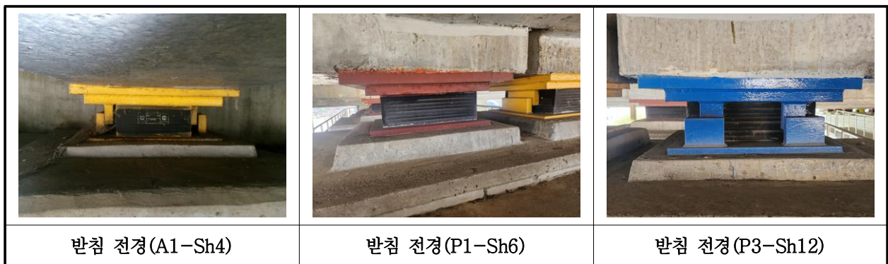
【사진 1.3.12】 교량받침 전경
