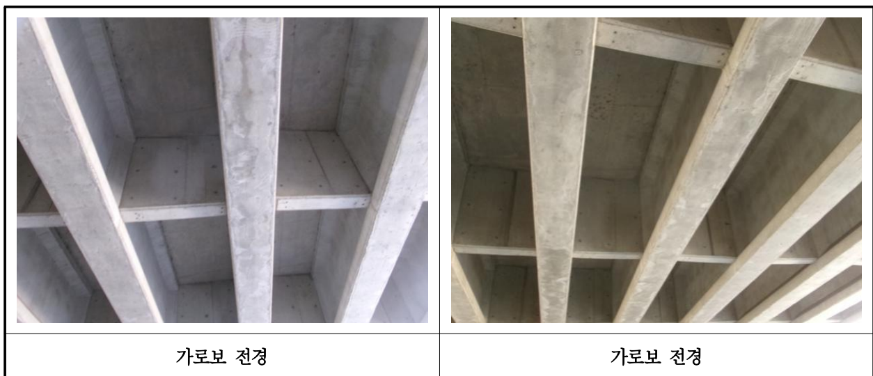
【사진 1.3.6】 가로보 전경
