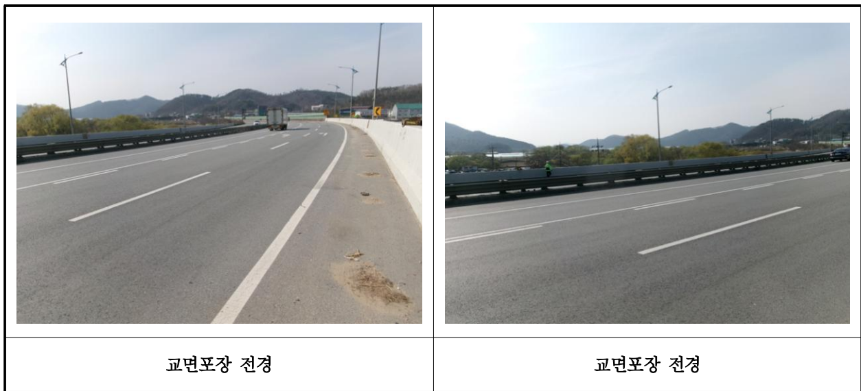
【사진 1.3.17】 교면포장 전경
