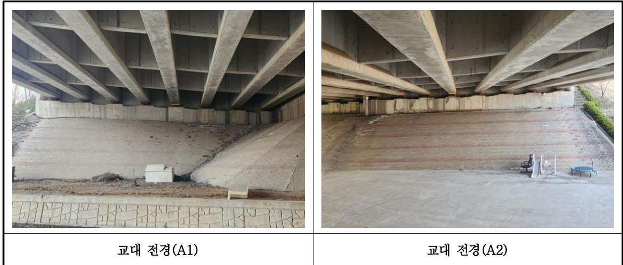
【사진 1.3.8】 교대 전경
