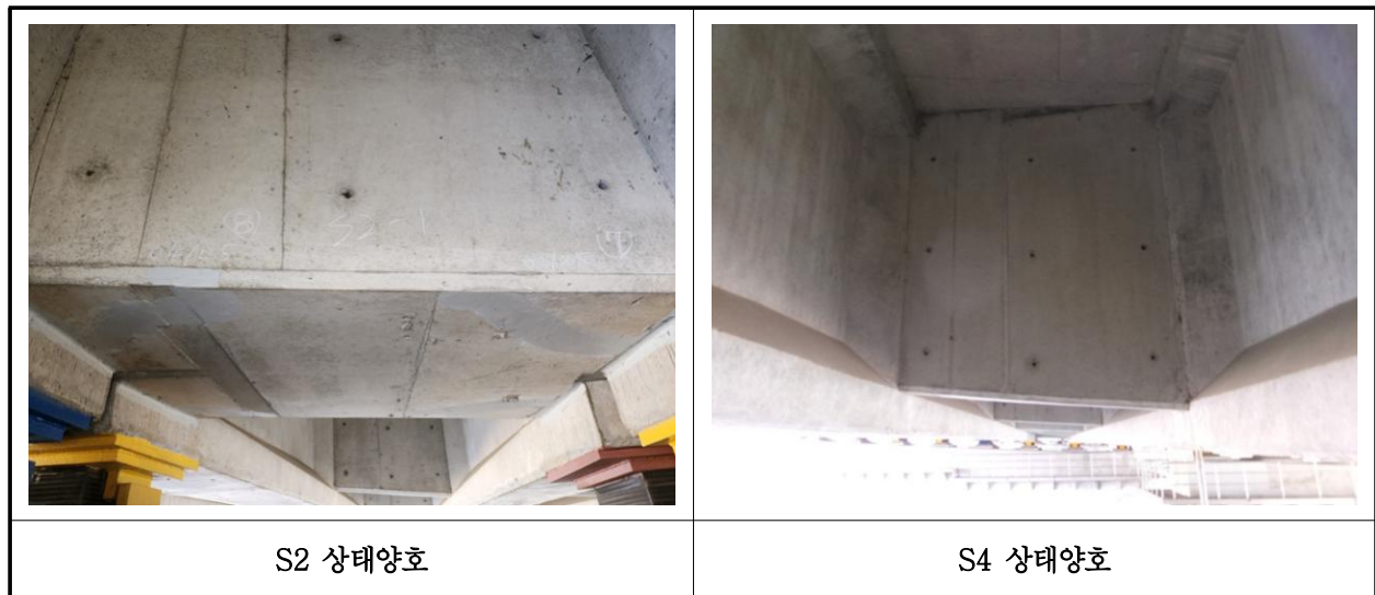
【사진 1.3.7】 가로보 손상현황
