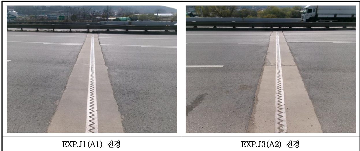
【사진 1.3.14】 신축이음장치 전경
