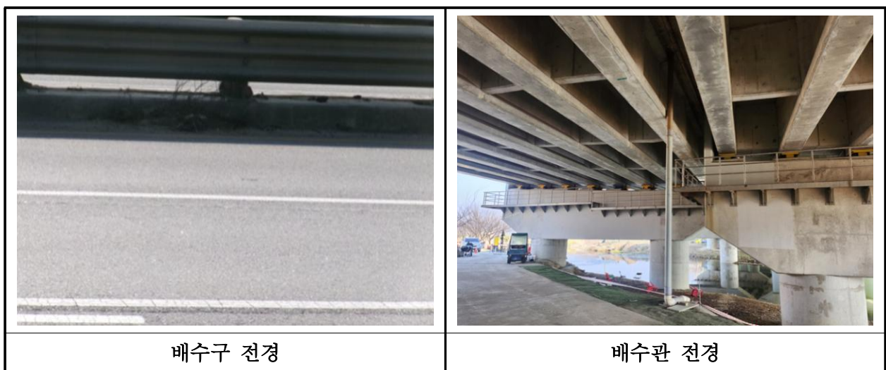
【사진 1.3.19】 배수시설 전경
