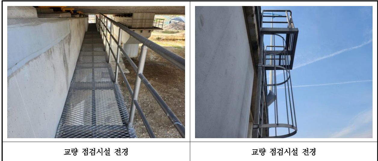
【사진 1.3.23】 교량 점검시설 전경
